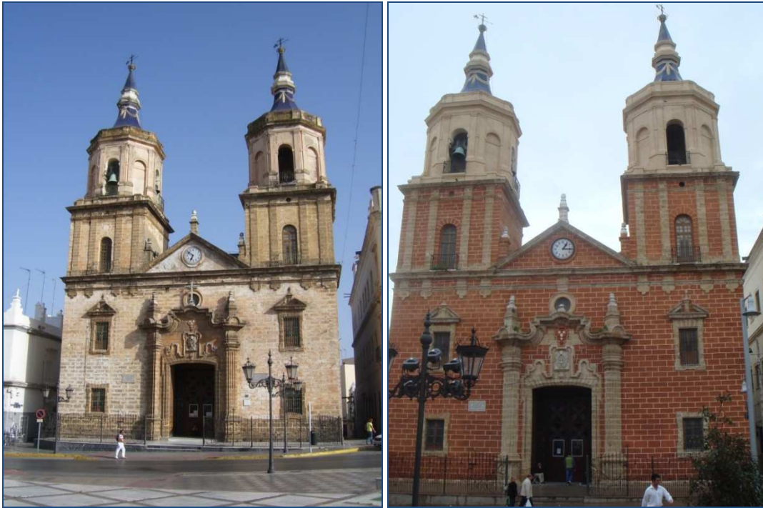
F. 3 y F. 4: Antes y después de la intervención sobre un edificio del siglo XVIII, donde se han eliminado los valores históricos que se encuentran traducidos en la pátina natural de los materiales, bien por una excesiva limpieza bien por una descomunal reintegración cromática.
