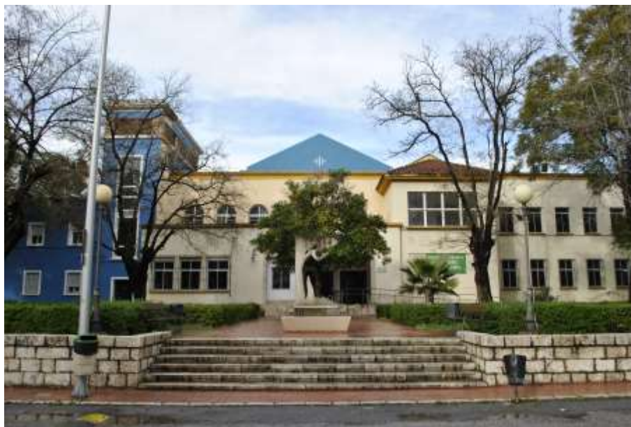
Figura 1. Fachada Sur de la Escuela de Formación Profesional, entrada alumnos. Fuente: propia.
